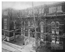
Fig. 7. Façade principale de l'École des beaux-arts de Québec, 1933-1934.
