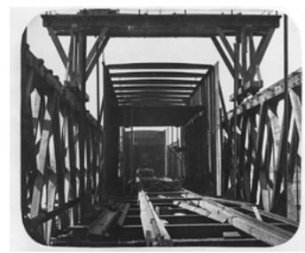
Fig. 6. William Notman, *Vue de l'intérieur de la structure du tube et échafaudage, pont Victoria*, Montréal, 1859. Notman est célèbre pour avoir photographié la construction de ce nouveau pont reliant le Canada et les États-Unis.
