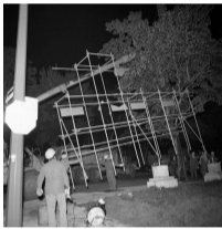
Démolition de Corridart , rue Sherbrooke, 13 et 14 juillet 1976. Crédit photographique : Louis-Philippe Meunier, Archives de la ville de Montréal, VM94-EM0752-008.
