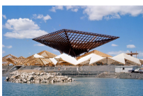
Construction du Pavillon du Canada à l'Exposition universelle de 1967, 1966, photographe inconnu. Collection de Bibliothèque et Archives Canada, Ottawa (e011171632-v8). Avec l'aimable autorisation de Bibliothèque et Archives Canada/The Brechin Group Inc.
